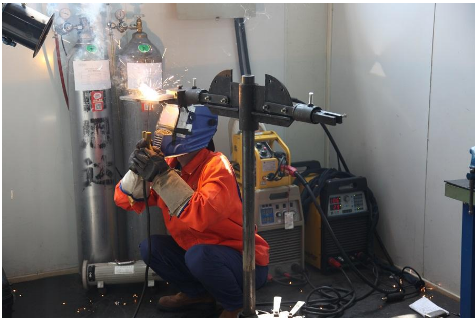
图 4：仰焊实际操作
