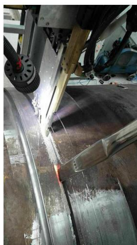
图 5：现场环缝焊接过程
